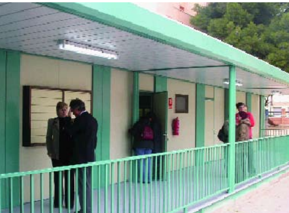
Aulas prefabricadas del colegio Cervantes
