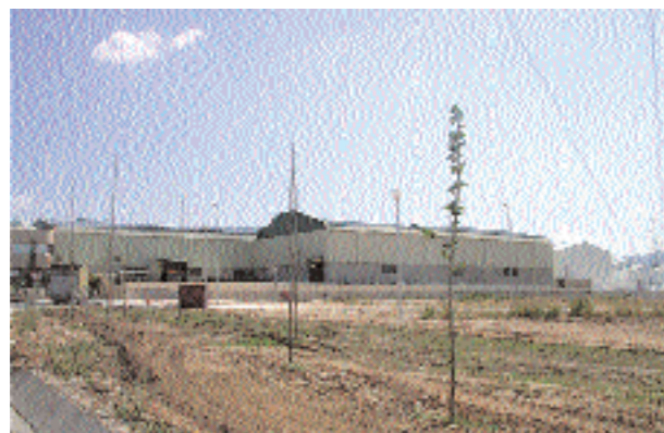
Solar donde se construirá el futuro Centro de Innovación.
