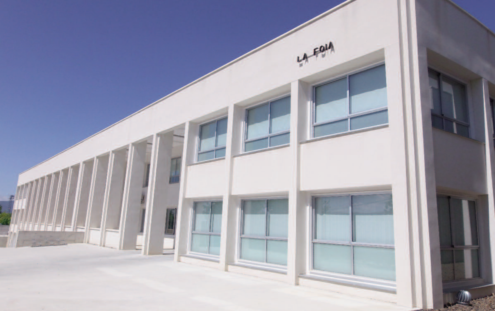
Edificio actual del IES La Foia
