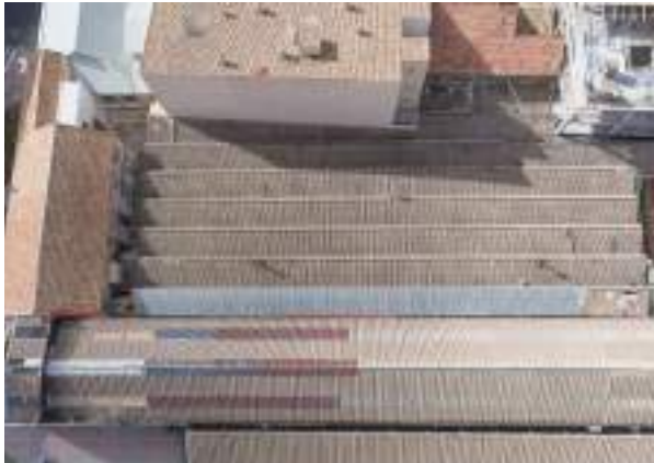
Foto 6.7.3 - Cubierta de diente de sierra de la nave 2
