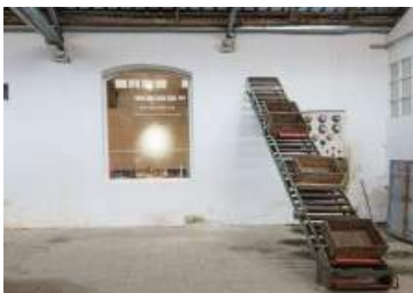
Foto 6.3.1 - Revestimiento continuo interior+ pintura (R2) en PO-2.01
