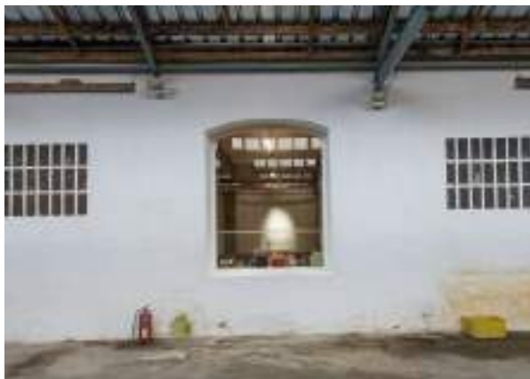
Foto 5.2.3.13 - Antiguo hueco de paso entre la nave 2 y 3
