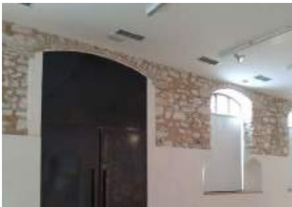
Foto 6.3.32 - Muro sin revestimiento (R0) en PO-5.01
