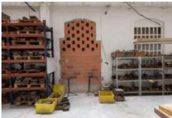
Foto 5.2.3.11 - Huevo de paso tapiado entre la nave 3 y nave 4
