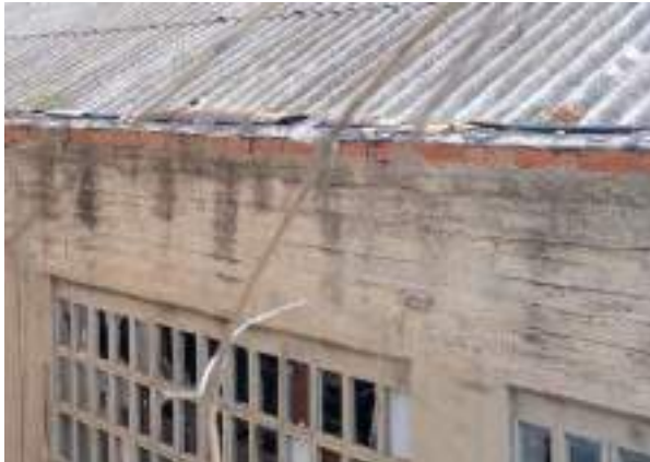
Foto 6.3.35 - Revestimiento continuo exterior (sin pintura, nave 4)
