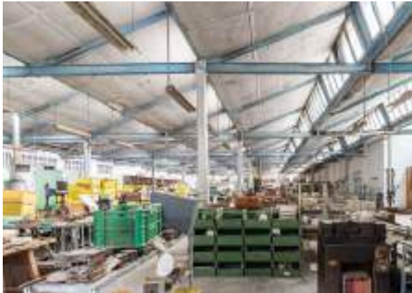
Foto 6.6.2 - Estructura mixta en la nave 2 (PO-2.01)
