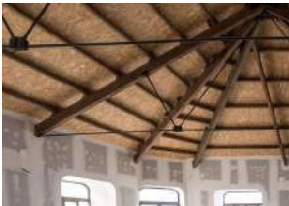
Foto 6.4.7 - Techo tipo F9 en la sala PE-1.01
