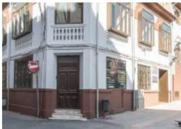
Foto 5.2.3.4 - Fachada de la nave 1 en 2019. Acceso actual
