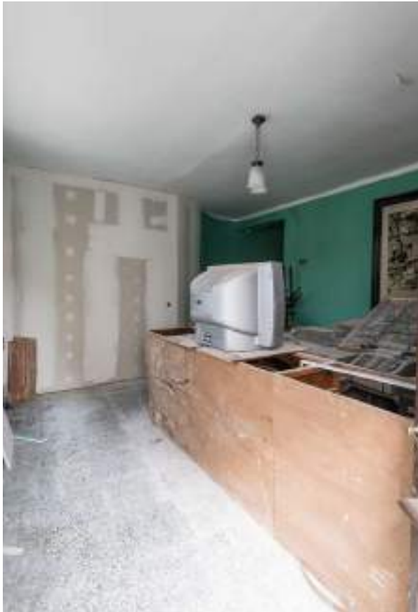
Foto 4.2.1.1 - Sala PO-1.01. Acceso a las naves desde el exterior
