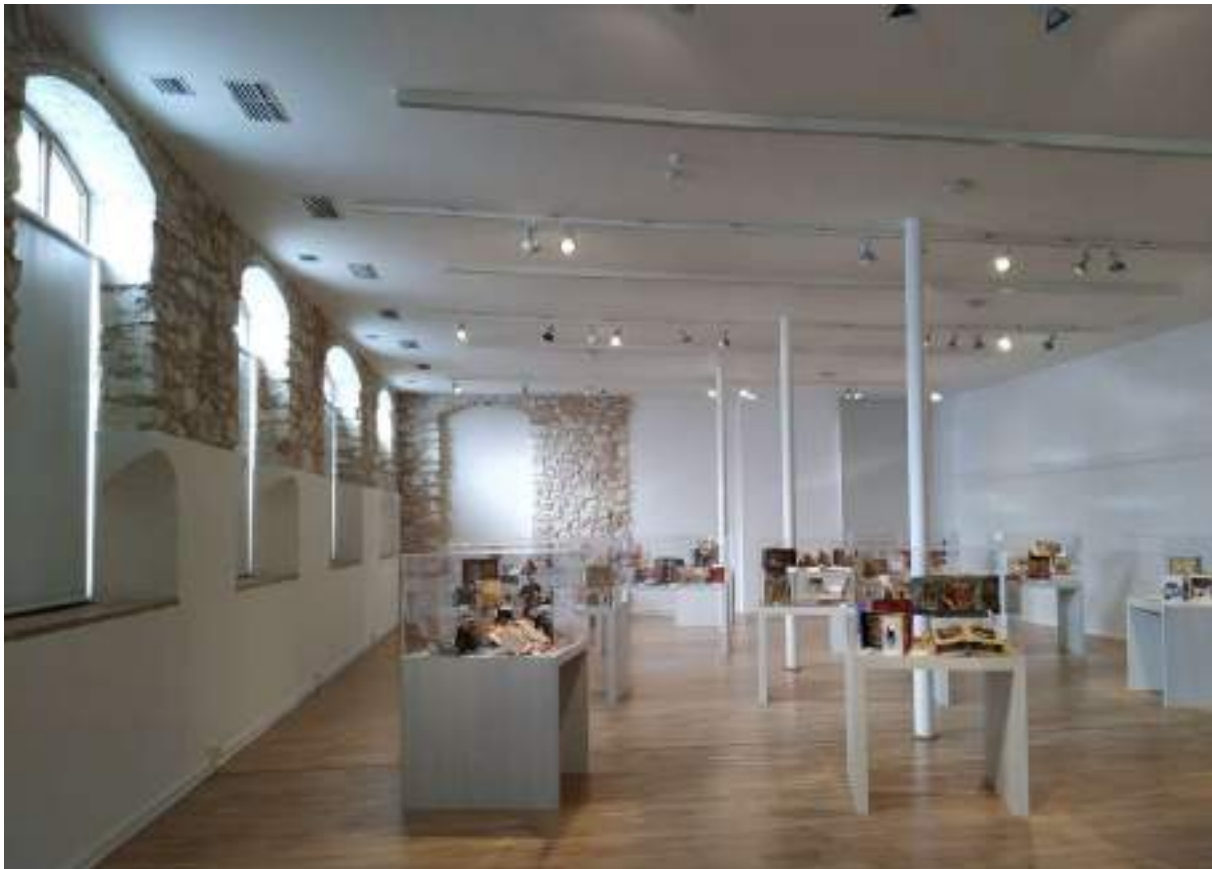
Foto 6.6.23 - Muro de piedra de la fachada oeste en la sala PO-5.01
