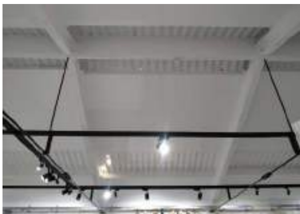
Foto 6.6.21 - Estructura de hormigón para la cubierta (P1-3.02)
