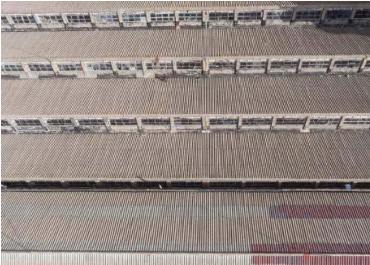
Foto 6.7.16 - Sistema de cubierta de dientes de sierra con fibrocemento en la nave 4
