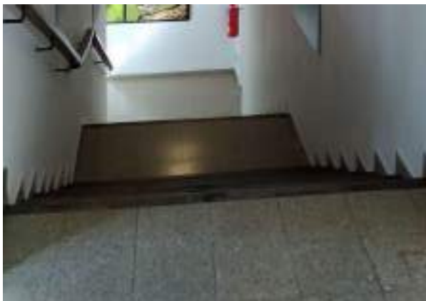
Foto 6.2.16 - Pavimento hidráulico de terrazo en las escaleras
