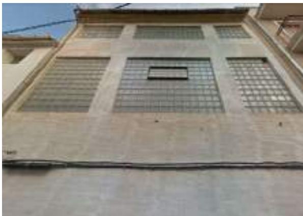
Foto 6.3.34 - Pavés en la fachada de la nave 2
