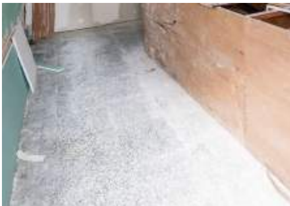
Foto 6.2.1 - Pavimento hidráulico de terrazo en la sala PO-1.01
