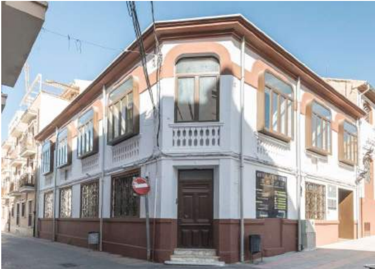
Foto 4.5.1.2 - Esquina suroeste de la fachada
