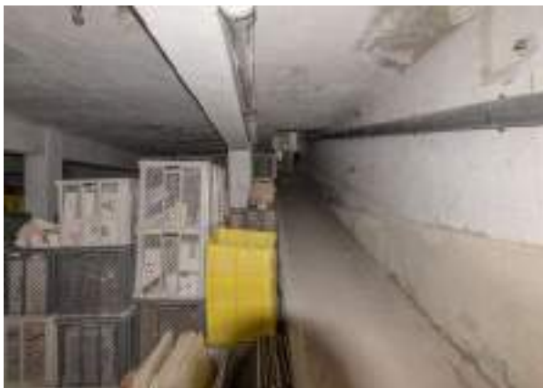
Foto 4.2.4.1 - Sala PS-2.01. Vista a la rampa sótano
