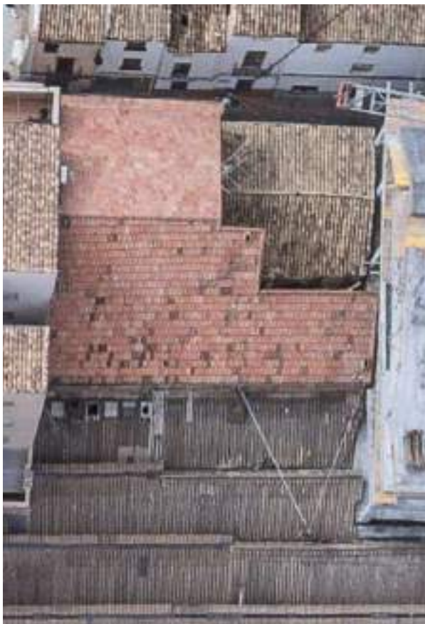
Foto 6.7.10 - Cubierta de teja a dos aguas en la nave 2
