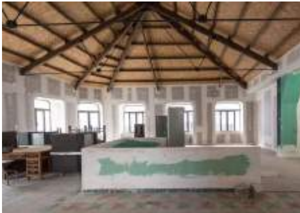
Foto 4.2.2.1 - Sala PE-1.01. Hueco de las escaleras
