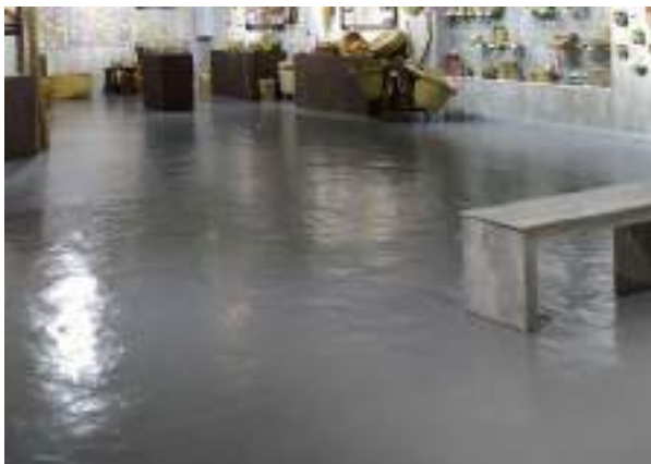
Foto 6.2.14 - Pavimento de linóleo en la sala P1-3.02
