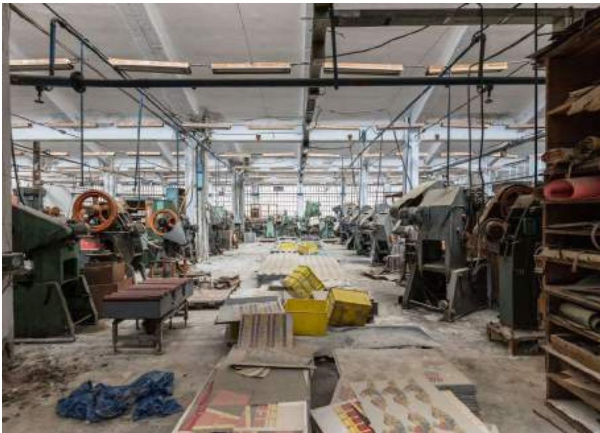
Foto 4.2.18 - Sala PO-4.01 mirando a la fachada norte
