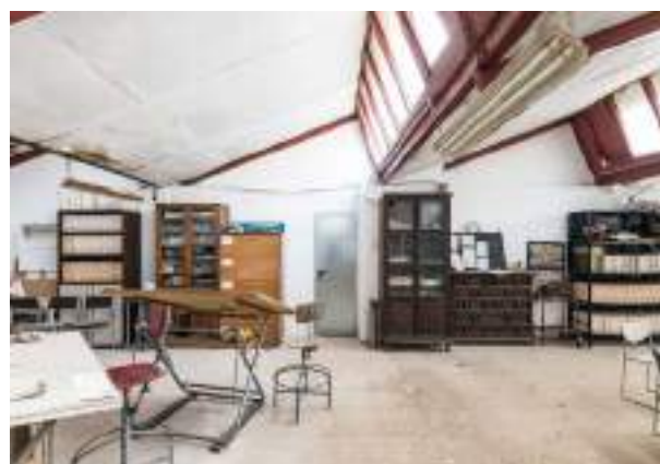
Foto 4.2.2.5 - Sala PE-2.01. Puerta hacia la sala PE-2.02
