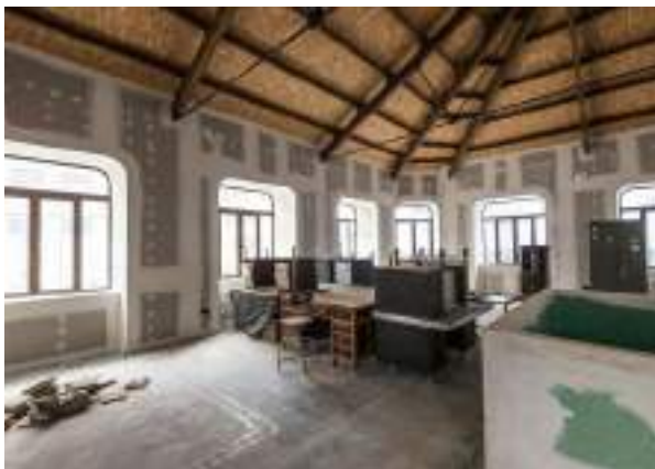
Foto 4.2.2.2 - Sala PE-1.01. Vista hacia las fachadas sur y este
