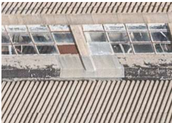
Foto 6.7.17 - Reparaciones puntuales en la cubierta de la nave 4
