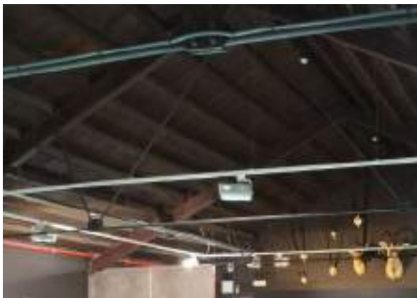
Foto 6.4.23 - Techo tipo F9 en la sala P1-5.01
