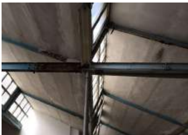
Foto 6.4.11 - Cambio de estructura cubierta
