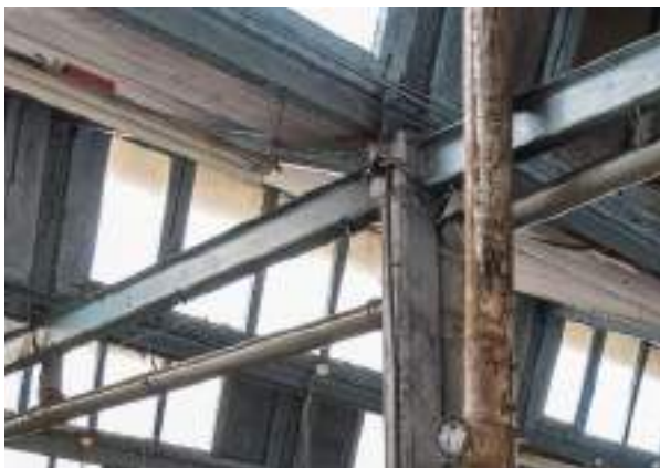
Foto 6.6.7 - Encuentros entre pilares, vigas, estructura de cubierta
