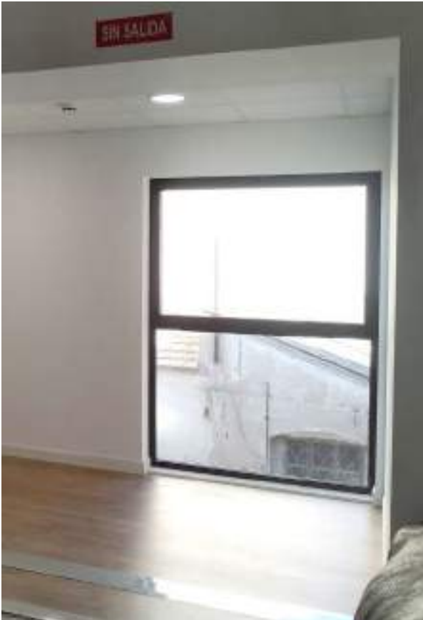
Foto 6.5.23 - Carpintería de ventana en ampliación de P1-1.01
