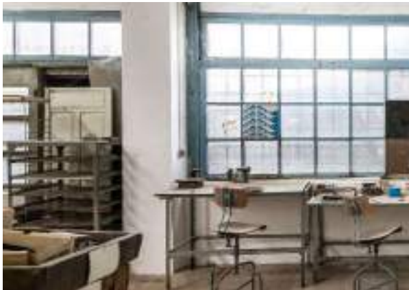
Foto 6.5.9 - Carpinterías de ventana en muro oeste (PO-2.01)
