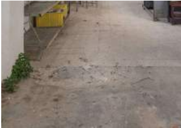
Foto 6.2.8 - Recreido por el cambio de pavimento (PO-2.01)
