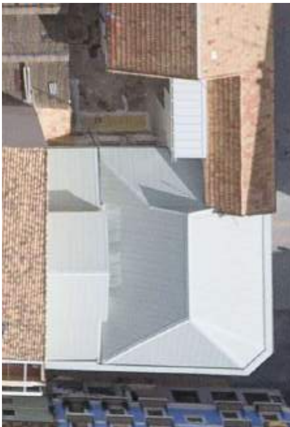
Foto 6.7.1 - Intervención de cubierta con chapa en la nave 1
