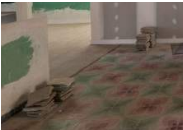
Foto 6.2.3 - Pavimento de terrazo y parquet en la sala PE-1.01
