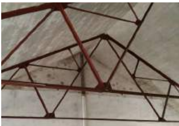
Foto 6.7.11 - Estructura portante de la cubierta a dos aguas (P1-2.01)
