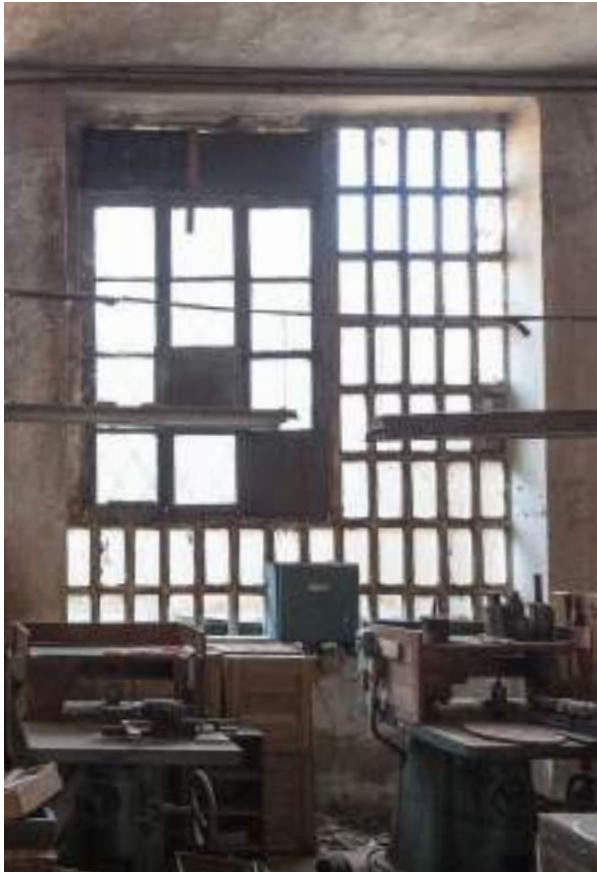
Foto 6.5.14 - Carpinterías de ventana en muro oeste (PO-3.01)
