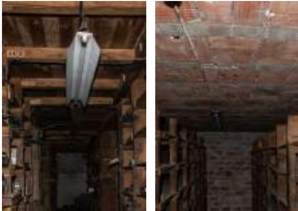
Foto 6.4.6 - Techo tipo F7 (izq.) y F8 (der.) en P0-3.02 y PE-3.01
