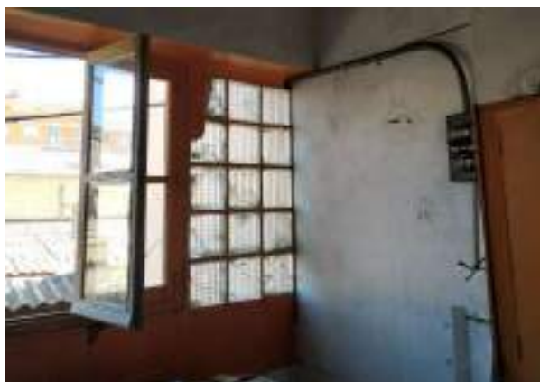
Foto 6.5.20 - Carpintería de ventana en la sala P1-2.01
