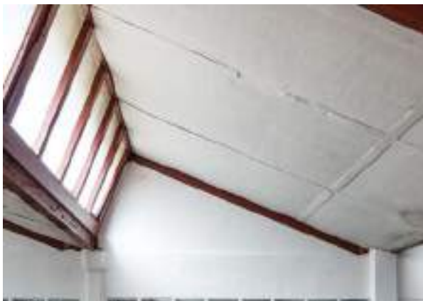
Foto 6.4.1 - Techo tipo F1 en la sala PE-2.01
