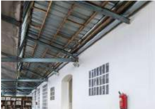
Foto 6.4.2 - Techo tipo F2 en la sala PO-2.01
