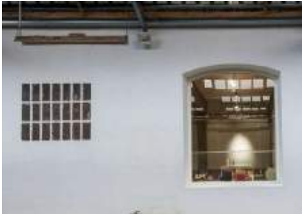
Foto 6.5.10 - Carpinterías de ventana en partición entre naves
