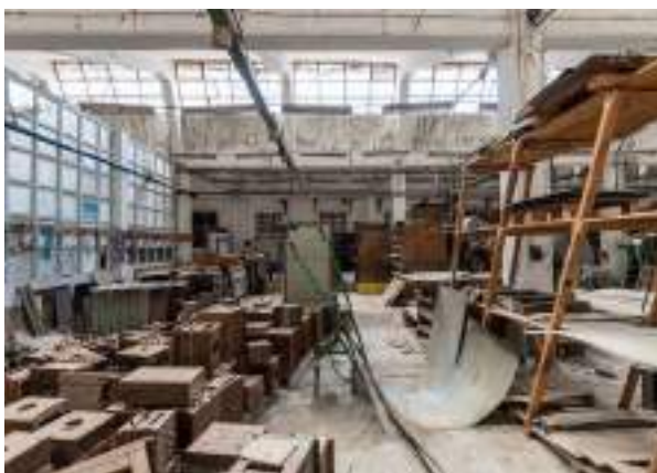
Foto 4.2.19 - Sala PO-4.01 mirando desde la fachada norte
