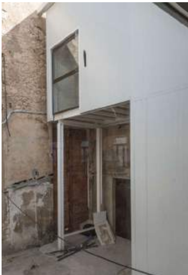
Foto 6.6.19 - Estructura realizada para la ampliación con ascensor
