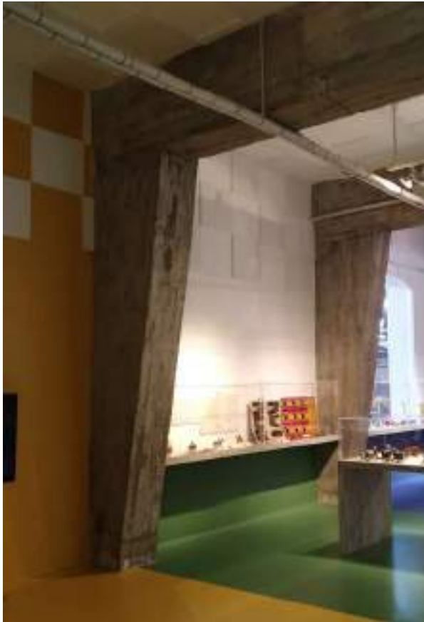
Foto 6.6.22 - Pórtico de hormigón en la sala PO-3.03
