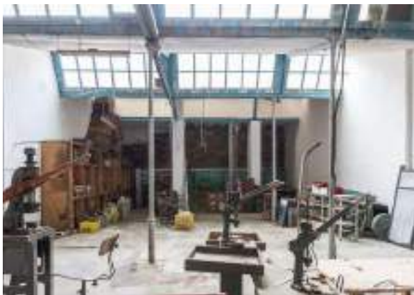
Foto 5.2.3.18 - Zona de la sala PO-2.01 anexo al cuerpo principal
