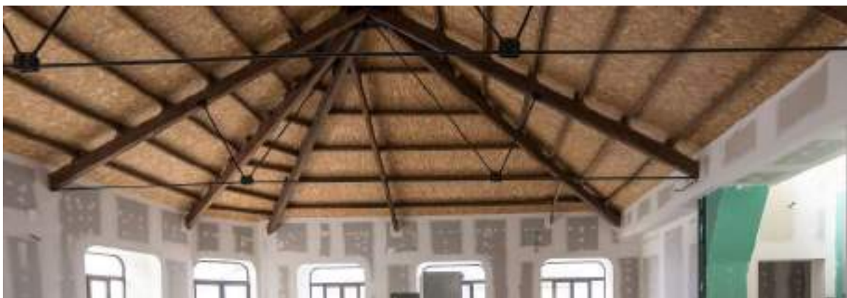
Foto 6.7.2 - Estructura de madera portante de la cubierta de la nave 1
