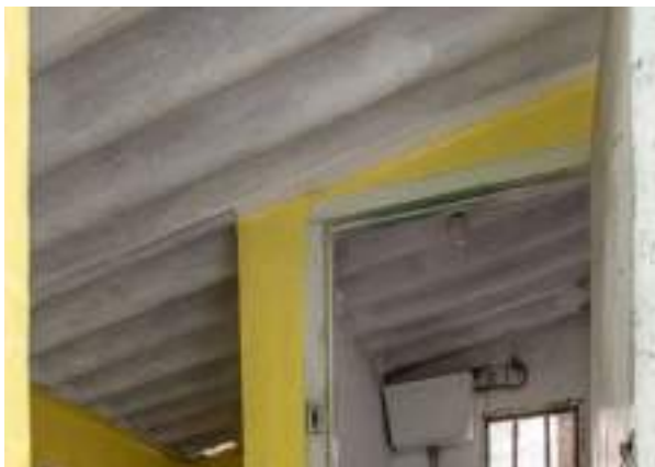
Foto 6.4.5 - Techo tipo F6 en la sala P0-2.14
