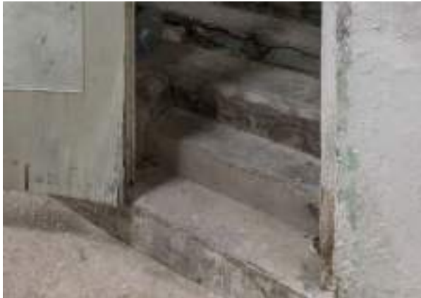
Foto 6.2.10 - Pavimento de los escalones
