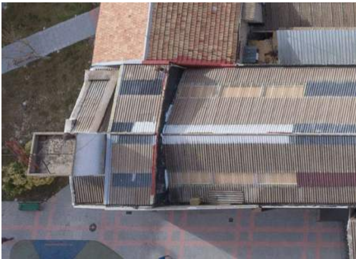
Foto 6.7.14 - Cubierta a dos aguas de fibrocemento en la nave 3
