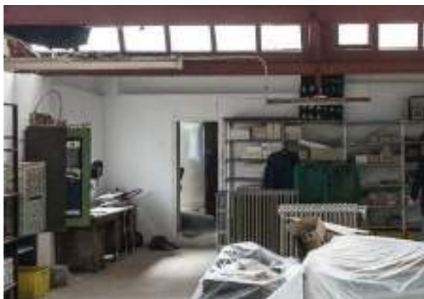
Foto 10.2.3.2 - Escalón entre la nave 1 y nave 2 en la entreplanta
