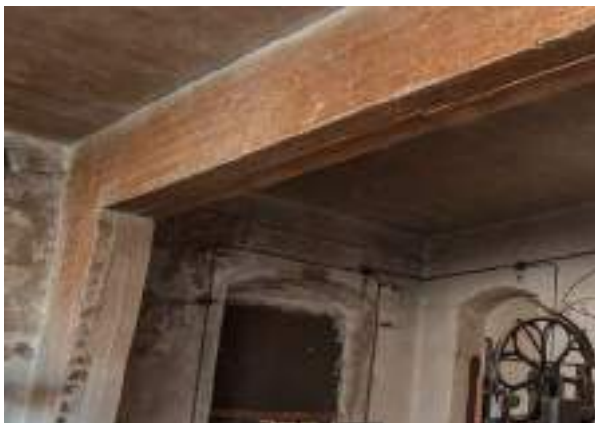
Foto 6.6.13 - Pórtico de hormigón en la sala PO-3.01
