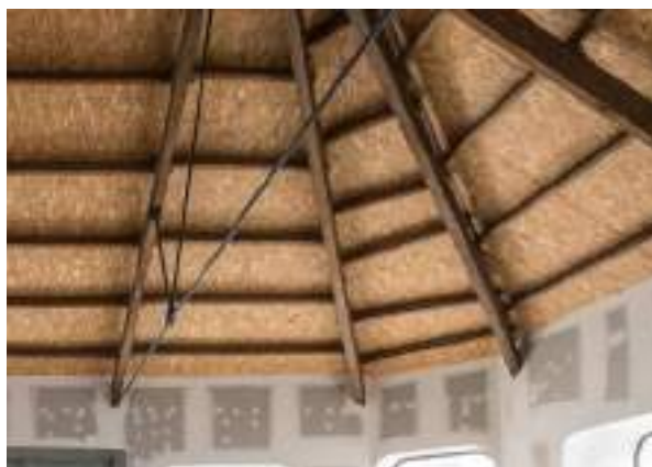
Foto 6.6.18 - Estructura de madera en la cubierta de la nave 1
