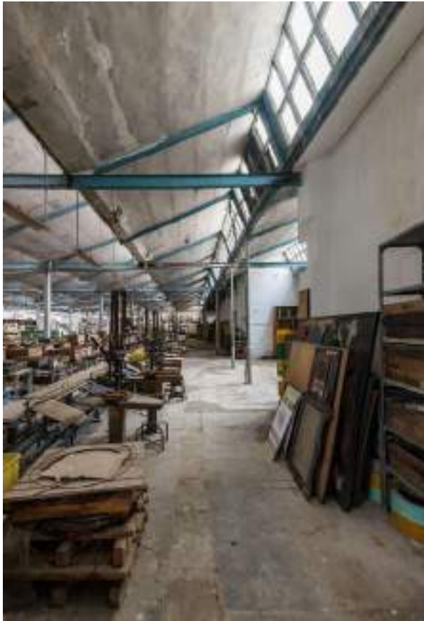
Foto 4.5.2.6 - Sala PO-2.01. Sección de cubierta de sierra de la nave 2
