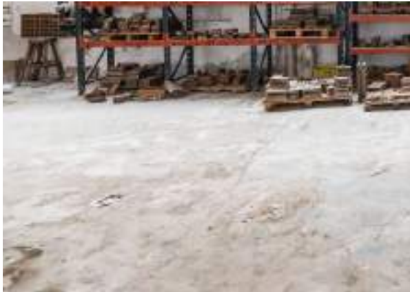
Foto 6.2.2 - Suelo de hormigón en la sala PO-4.01
