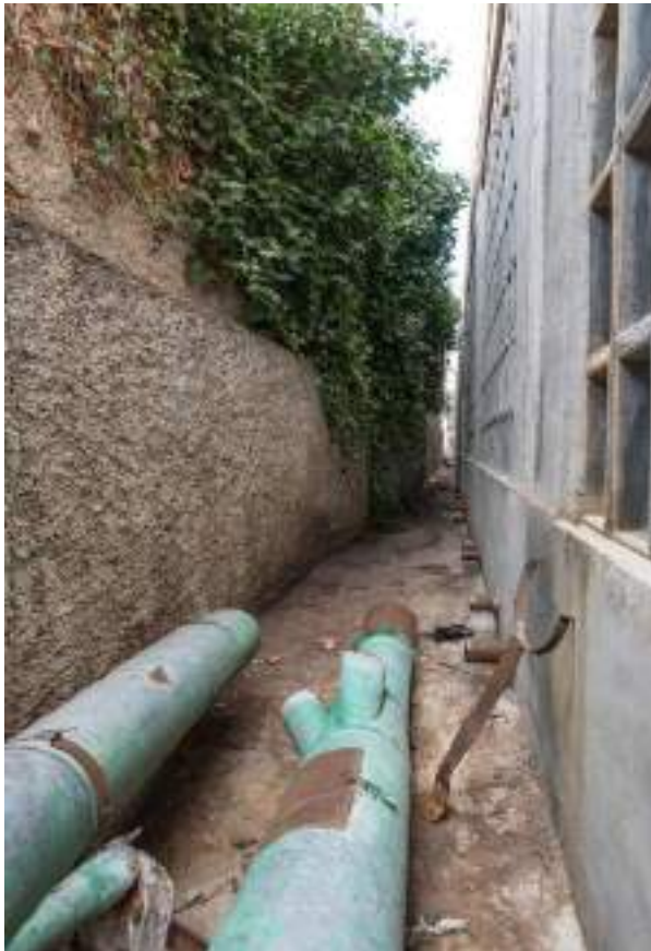
Foto 4.5.1.3 - Patio interior entre la fachada oeste y el muro perimetral
