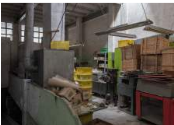
Foto 4.2.3.1 - Sala P0-2.02. Escaleras que comunica con la sala P1-2.01
