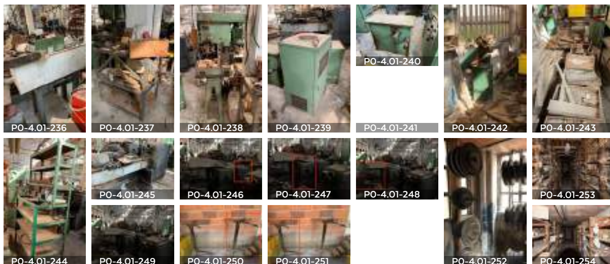
Fotos 7.2.2.9 - Mobiliario, maquinaria y contenido actual de la sala PO-4.01 (de la 236 hasta 254)
