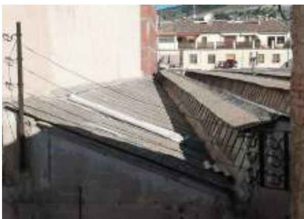
Foto 4.5.3.1 - Cubierta de la nave 2
