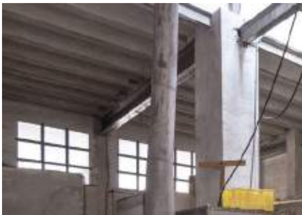
Foto 6.4.3 - Techo tipo F4 en la sala PO-2.02
