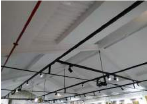
Foto 6.4.20 - Techo tipo F5 en la sala P1-3.02
