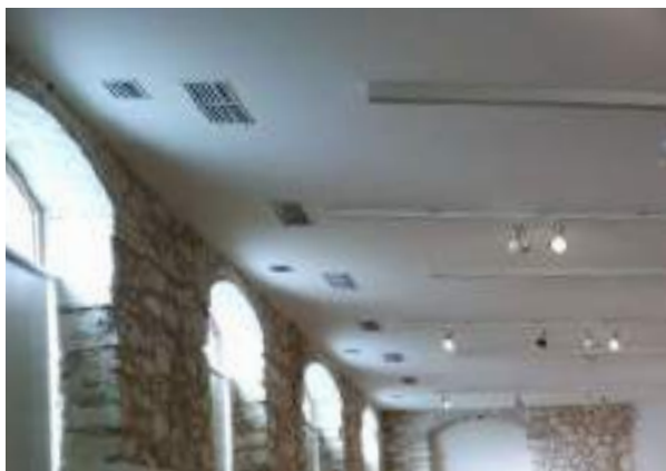
Foto 6.4.24 - Techo de la sala PO-5.01
