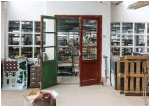
Foto 6.5.1 - Carpintería de madera. Puerta en sala PE-2.01
