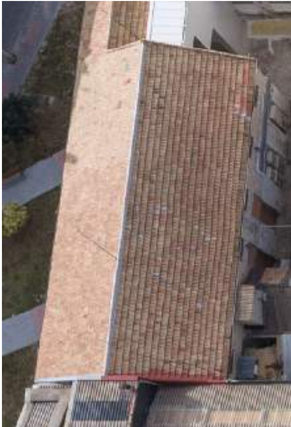
Foto 6.7.20 - Cubierta de teja a dos aguas en la nave 5
