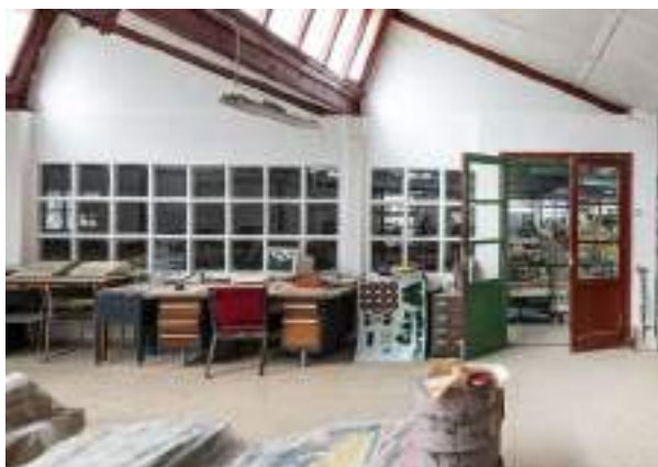
Foto 6.5.5 - Carpintería de separación entre PE-2.01 y PO-2.01
