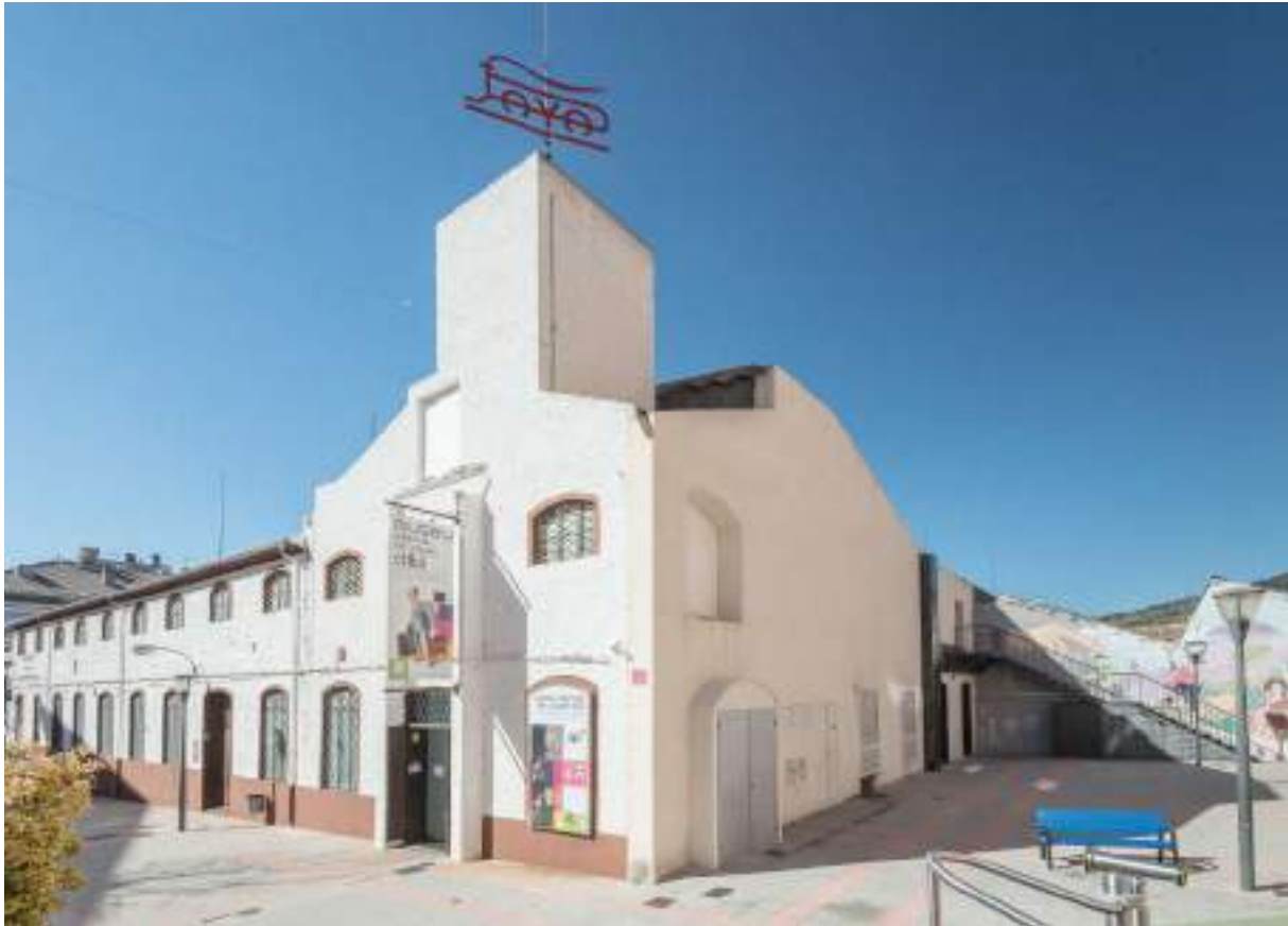
Foto 1.2.1 - Fachada principal del conjunto de naves
