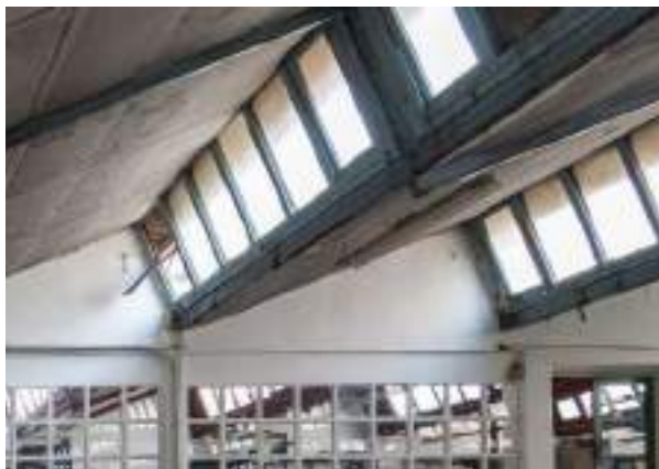
Foto 6.5.7 - Carpintería en cubierta en la sala PO-2.01
