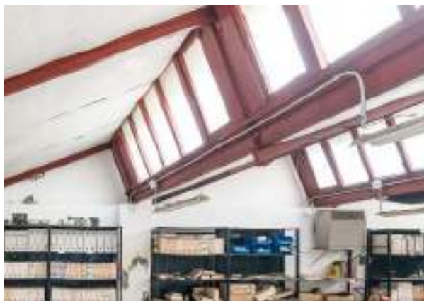
Foto 6.5.4 - Carpintería de cubierta en la sala PE-2.01
