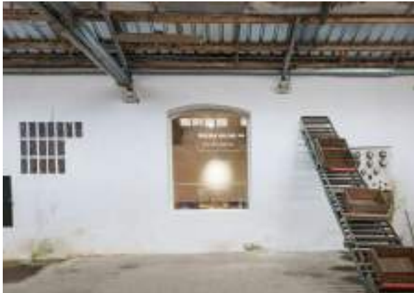
Foto 10.2.31 - Muro que separa las naves 2 y 3
