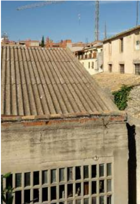
Foto 6.7.15 - Encuentro de la cubierta con la fachada (nave 4)
