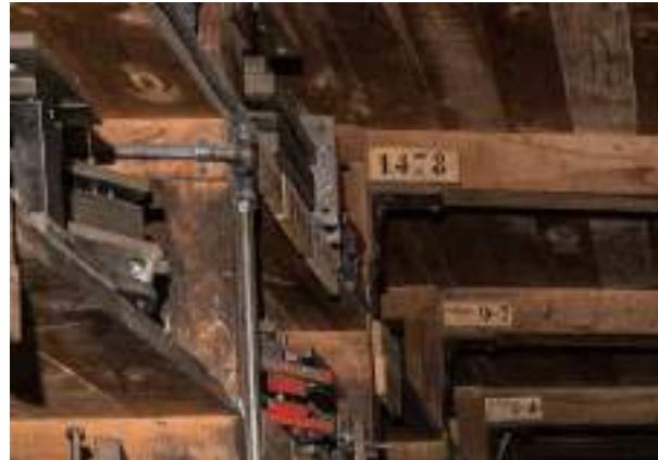
Foto 6.6.10 - Forjado de vigas de madera en la sala PO-3.02
