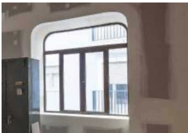
Foto 6.5.21 - Carpintería de ventana en la sala PE-1.01
