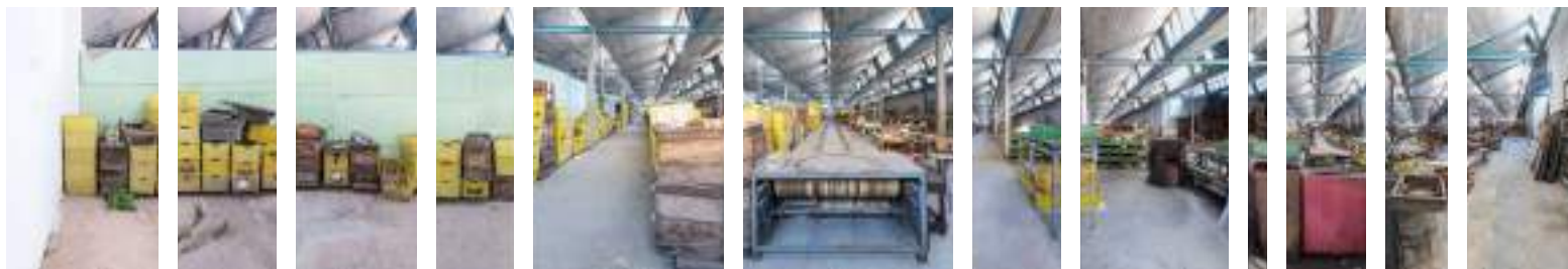
Fotografías 4.5.2.1 - Sección transversal de la sala PO-2.01 de la nave 2 (vista hacia la sala PE-2.01)
