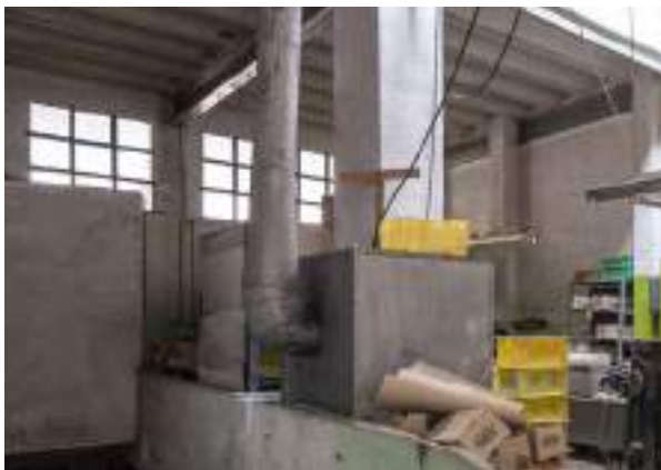
Foto 6.8.10 - Instalación en la sala P0-2.02
