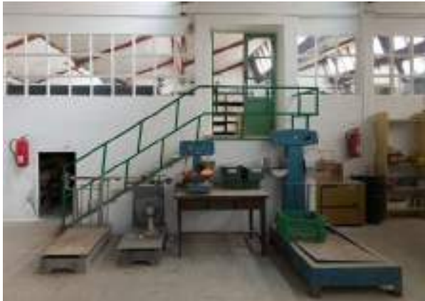
Foto 10.2.2.2 - Escaleras en la sala PO-2.01
