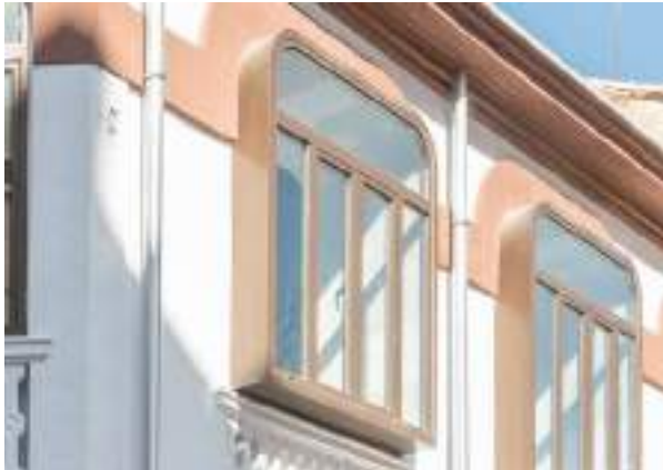
Foto 6.5.2 - Carpintería metálica. Ventana en fachada este
