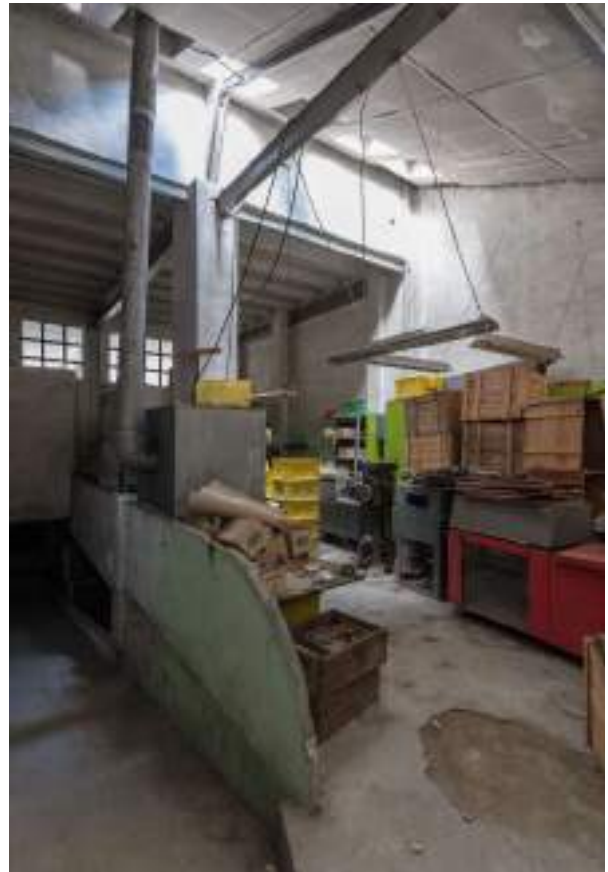
Foto 4.5.2.10 - Arranque de rampa y acceso de escaleras en PO-2.02
