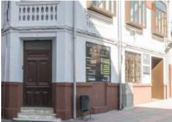
Foto 6.3.33 - Revestimiento continuo exterior + pintura (nave 1)
