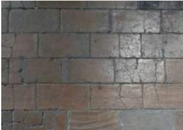
Foto 6.2.15 - Pavimento de baldosa cerámica en la sala P1-5.01
