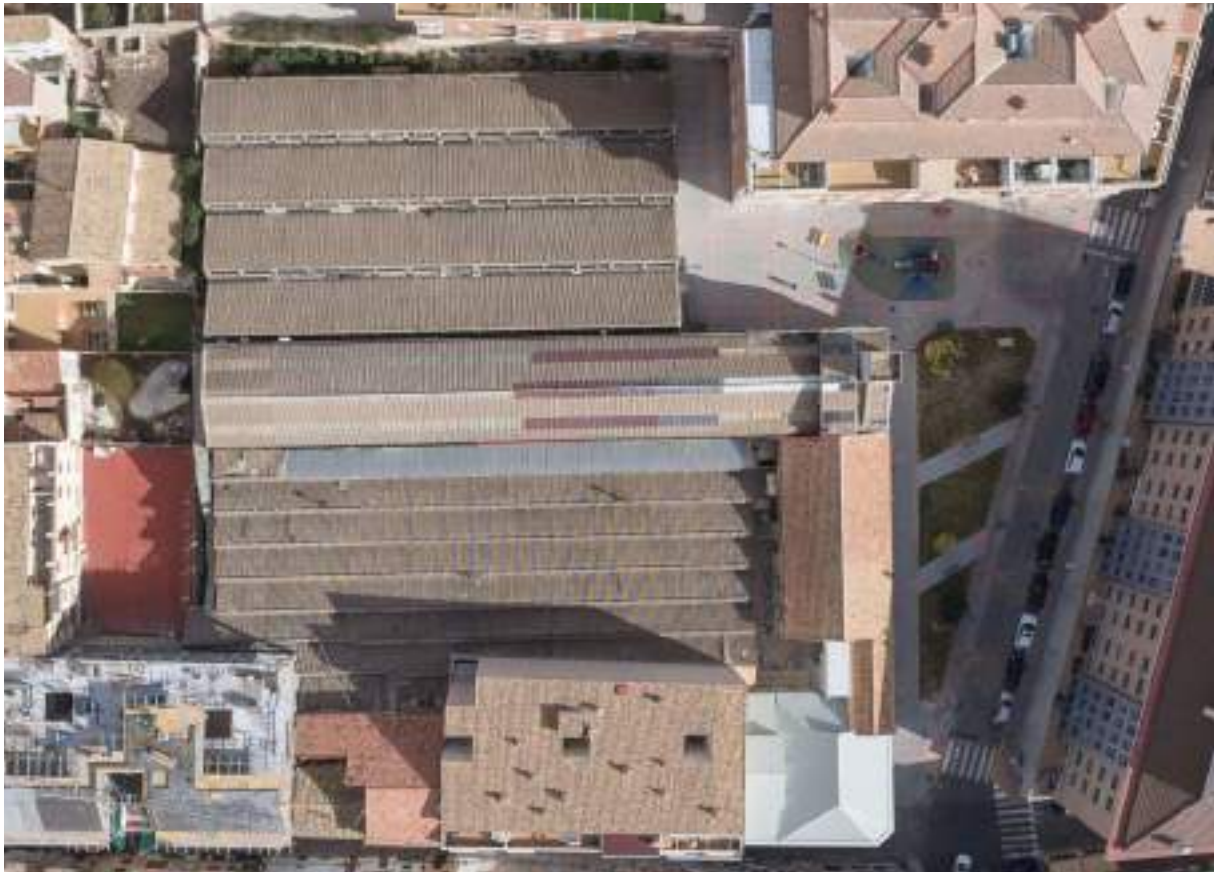
Foto 4.5.3.3 - Cubiertas de las cinco naves
