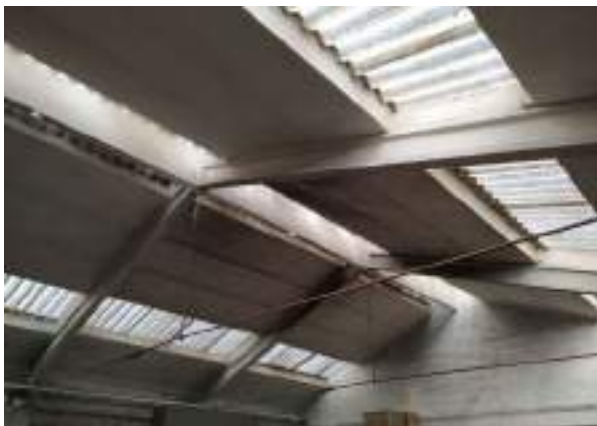
Foto 6.4.21 - Techo tipo F6 en la sala P1-3.03
