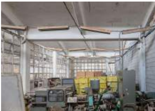
Foto 6.6.1 - Estructura de hormigón en la nave 4 (PO-4.01)
