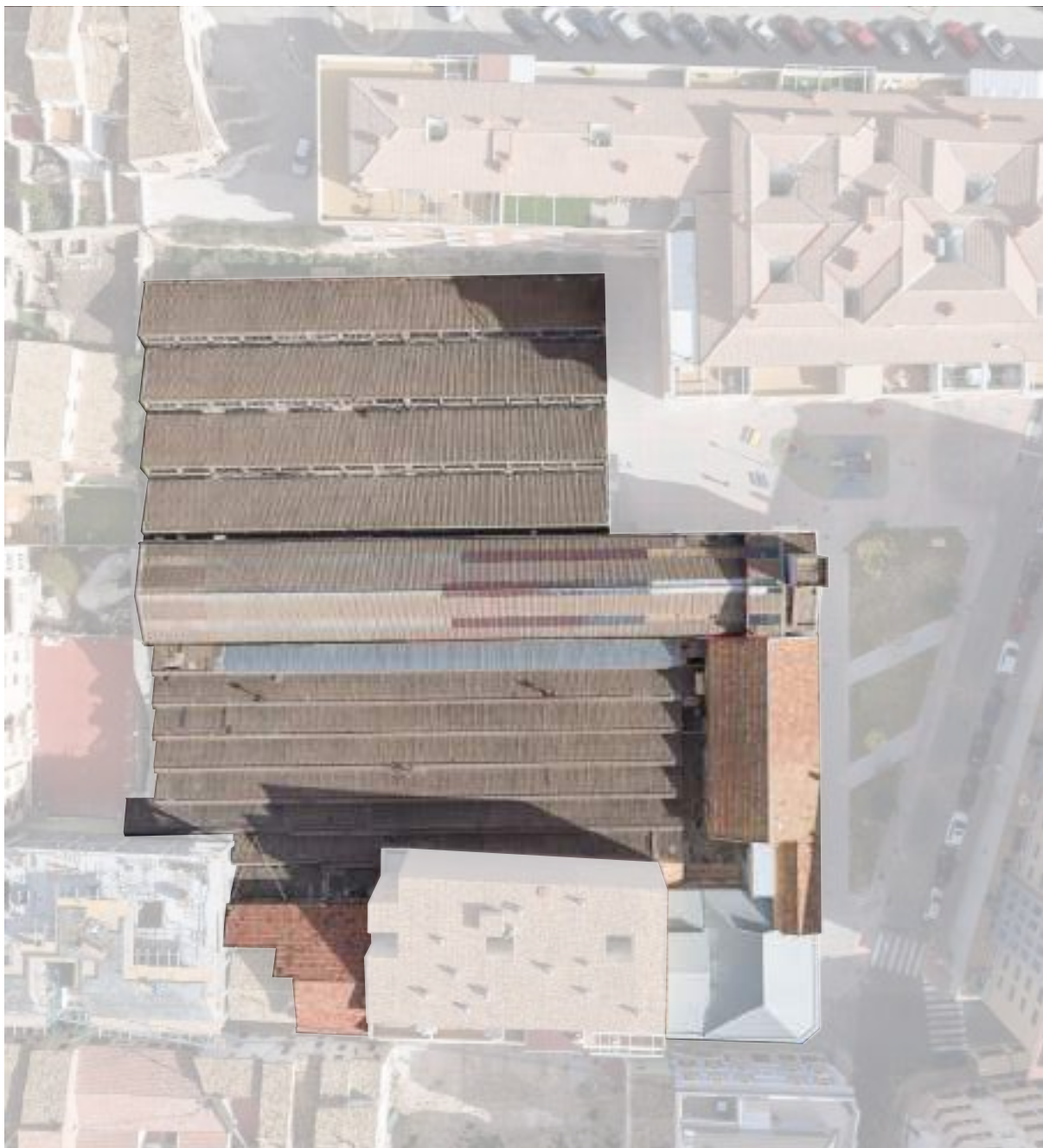
Foto 6.7.22 - Vista aérea de todas las cubiertas del conjunto de naves
