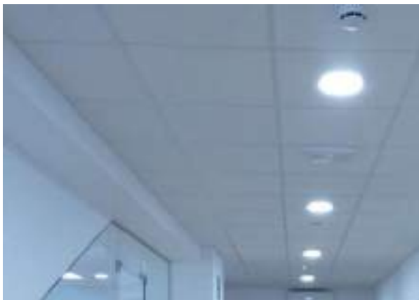
Foto 6.4.22 - Techo tipo F11 en la sala P0-1.02
