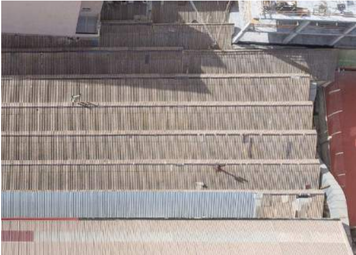
Foto 6.7.5 - Sistema de cubierta de dientes de sierra con fibrocemento e intervención en chapa en la nave 2
