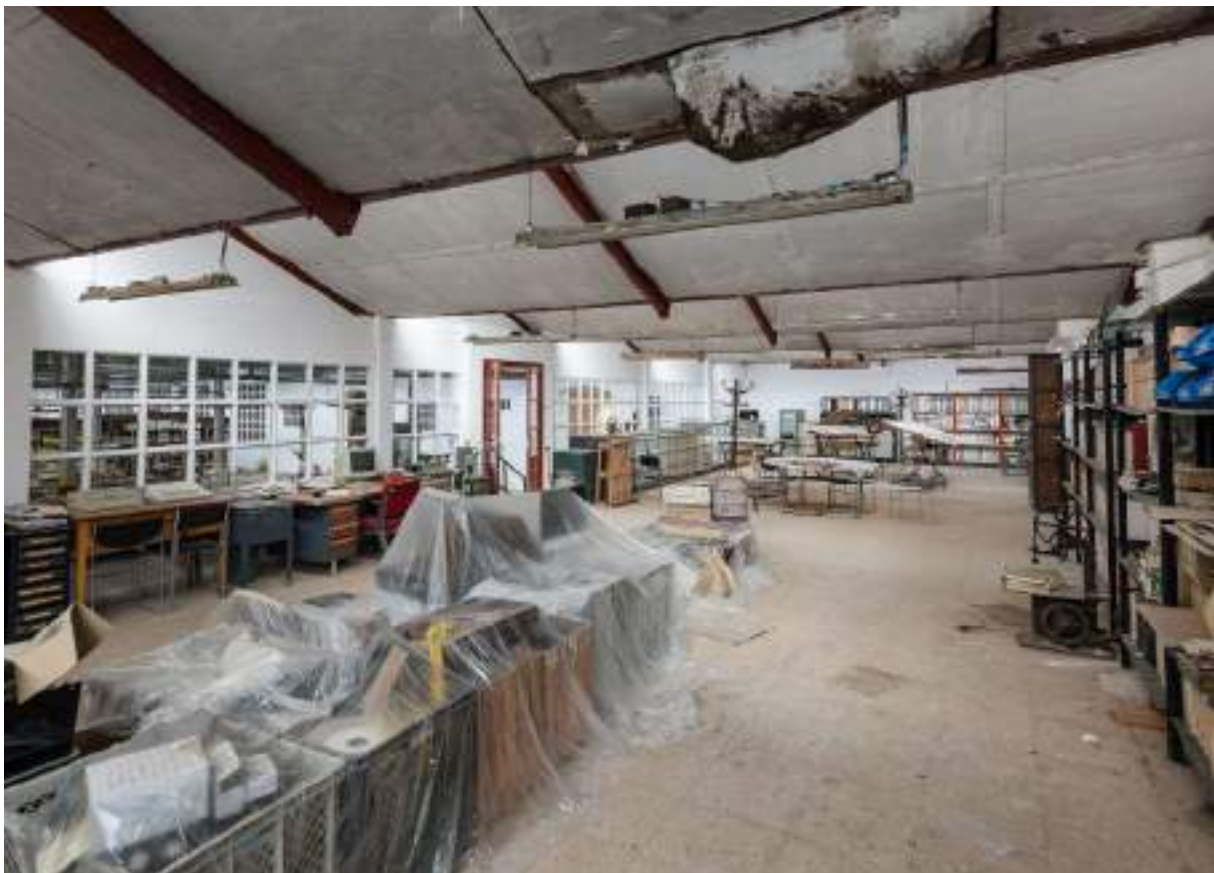
Foto 4.2.2.4 - Sala PE-2.01. Vista hacia la puerta a la sala PO-2.01
