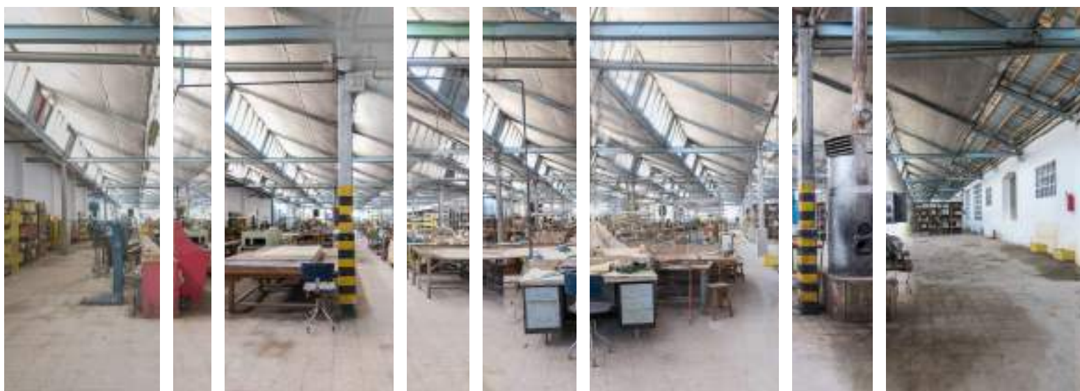
Fotografías 4.5.2.2 - Sección transversal de la sala PO-2.01 de la nave 2 (vista desde la sala PE-2.01)
