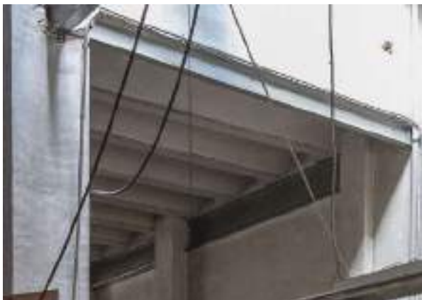
Foto 6.6.11 - Forjado de viguetas en la sala PO-2.02
