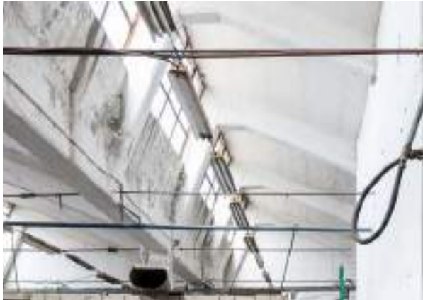
Foto 6.4.4 - Techo tipo F5 en la sala P0-4.01
