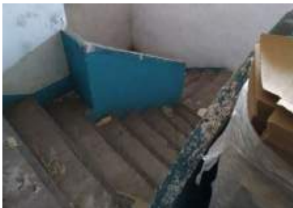
Foto 10.2.3.3 - Escaleras que conectan la PB y P1 de la nave 2
