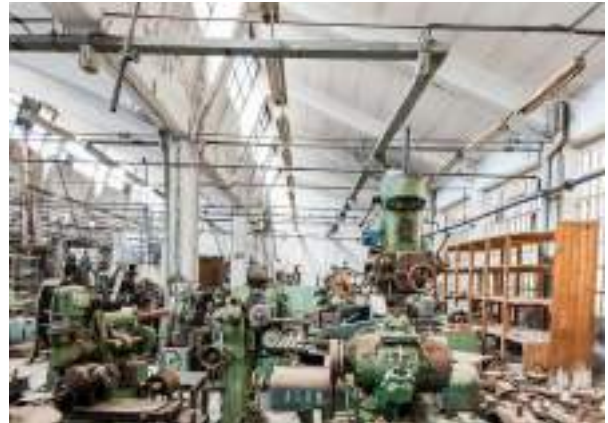
Foto 4.2.77 - Sala PO-4.01. Sección de la cubierta de sierra de la nave 4
