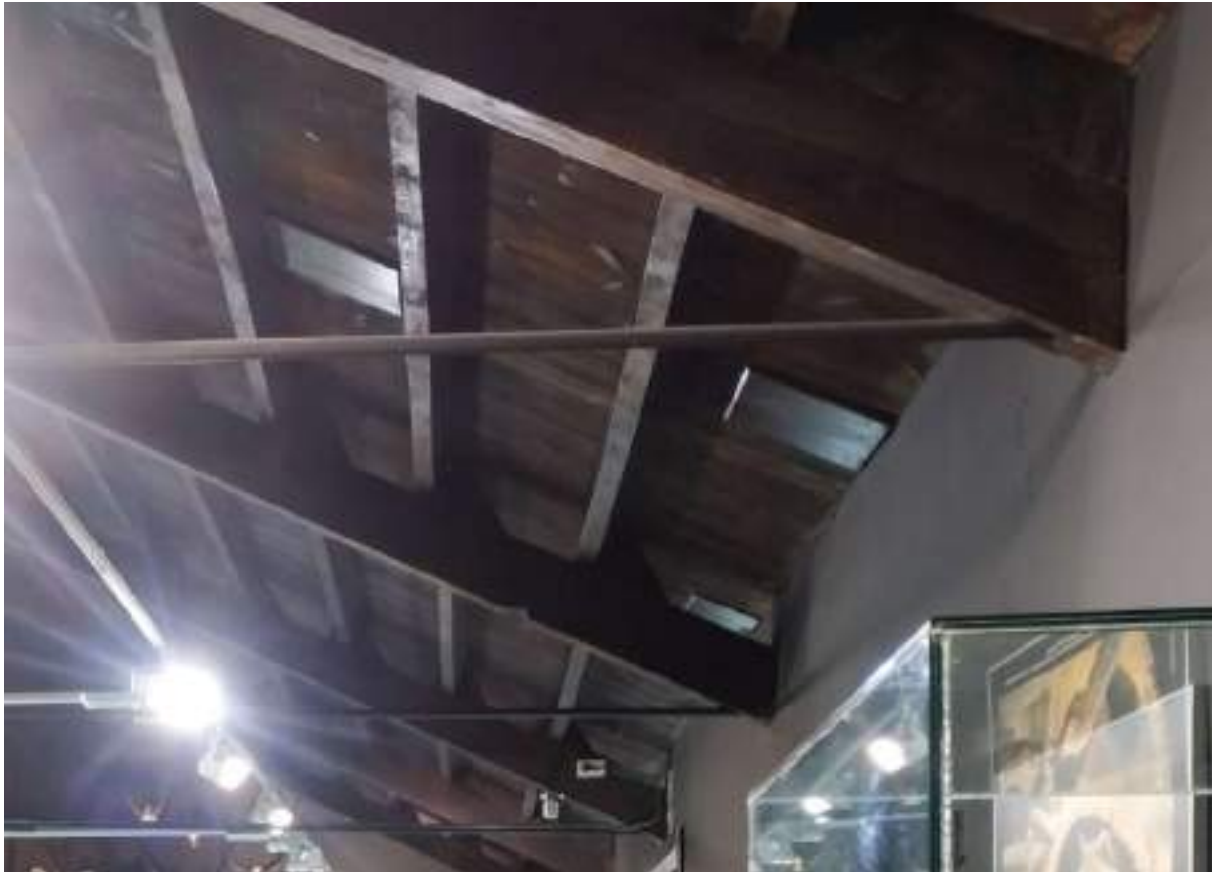
Foto 6.7.21 - Estructura portante de madera de la cubierta en la nave 5
