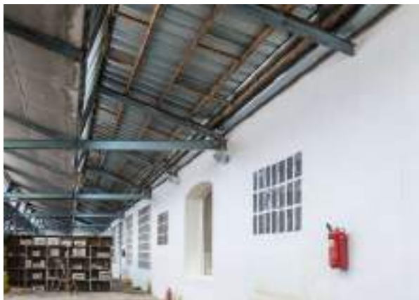
Foto 5.2.3.15 - Cambio de cubierta en la nave 2
