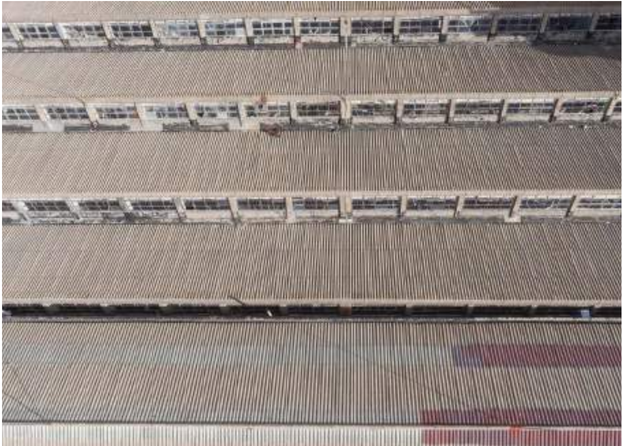
Foto 4.5.3.2 - Cubierta de sierra de la nave 4
