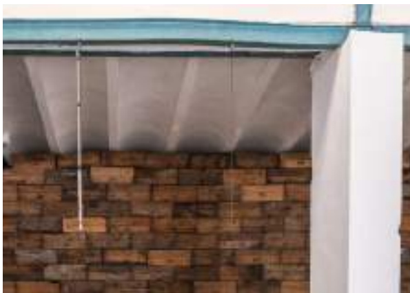
Foto 6.6.3 - Forjado unidireccional en la nave 2 (PO-2.01)
