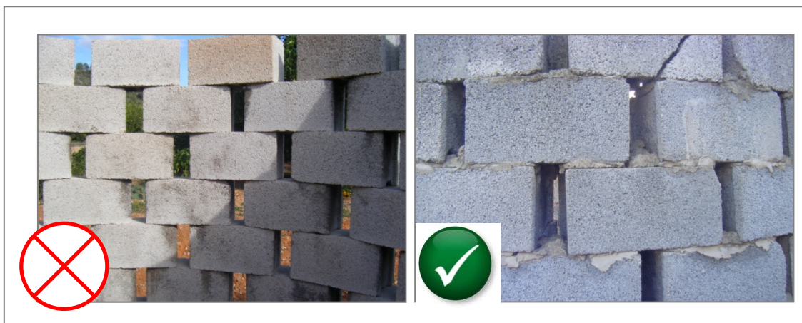
Foto 2. Construcción formada por bloques con y sin cemento de unión.
