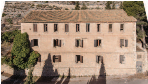
Foto 4.2.5.1 - Alzado sur visto desde drone
