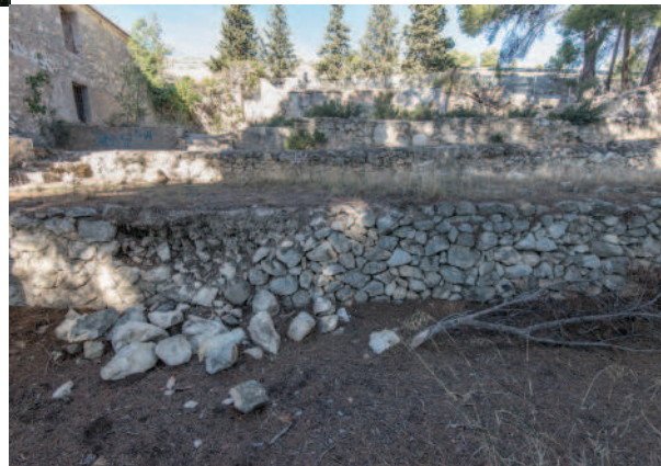
Foto 4.2.6.5 - Muros de mampostería formando niveles
