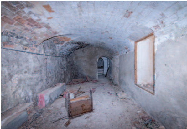
Foto 6.6.2 - Bóveda de cañón estructuralmente en buen estado
