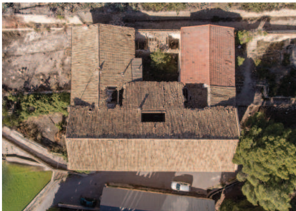
Foto 4.2.4.1 - Foto aérea de la cubierta.
