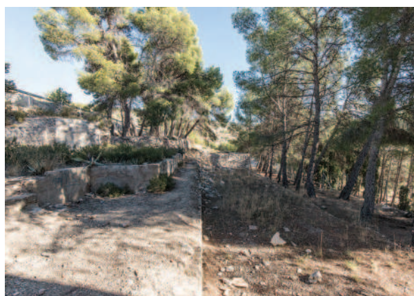
Foto 4.1.3.1 - Vista de la zona exterior este
