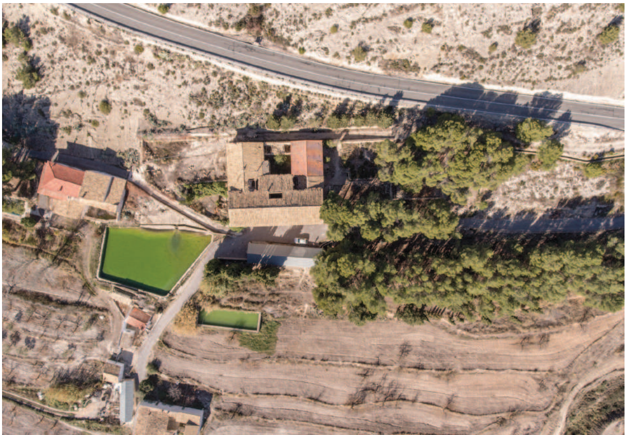
Foto 2.1.4 - Foto aérea del recinto
