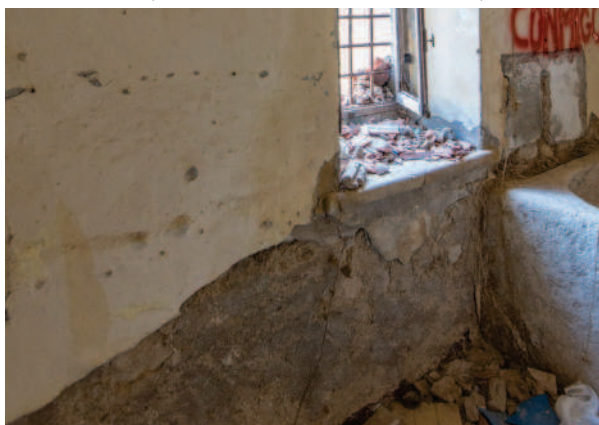
Foto 6.3.2 - Muro de piedra, acabado de yeso y pintura y muro visto
