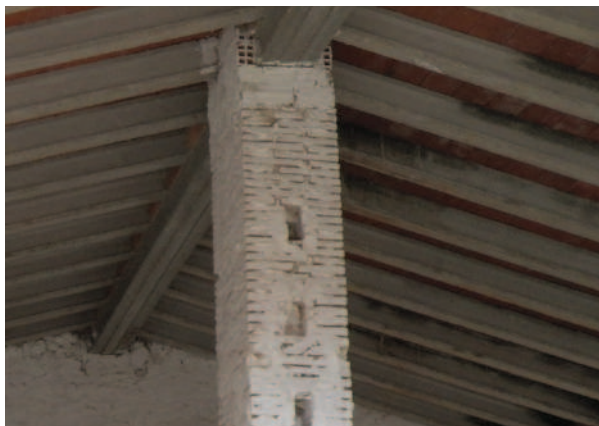
Foto 6.6.7 - Pilar de ladrillo cerámico macizo
