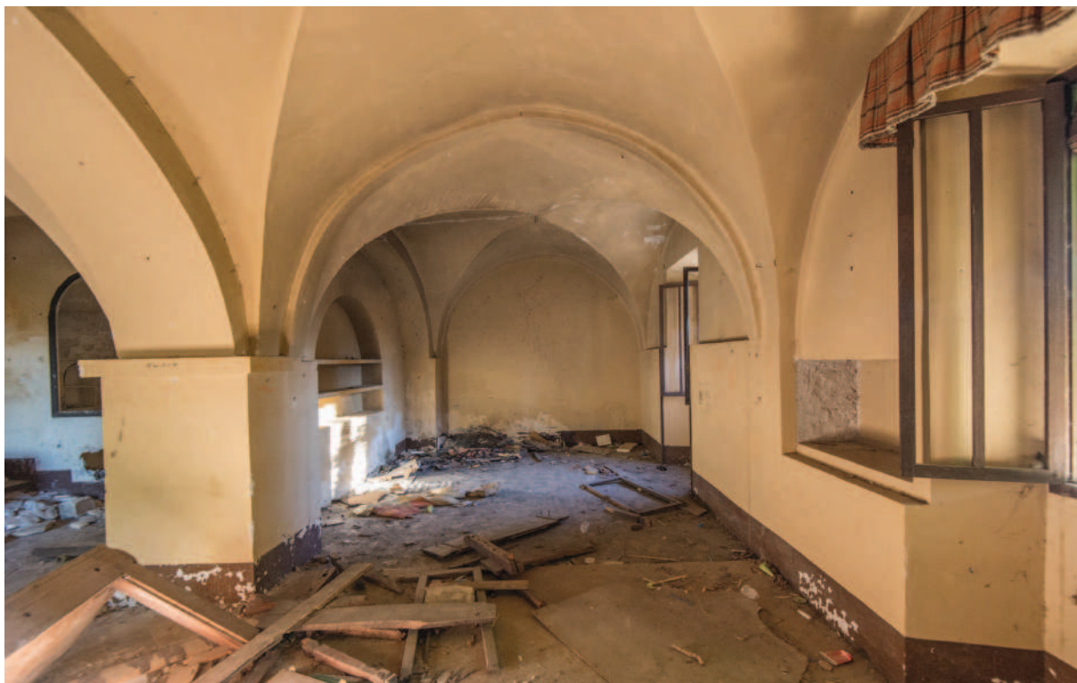
Foto 5.1.1.1 - Bóveda de arista
