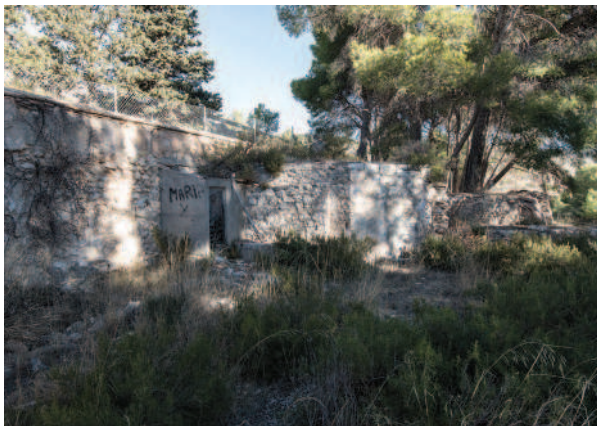
Foto 4.2.6.4 - Depósito de agua
