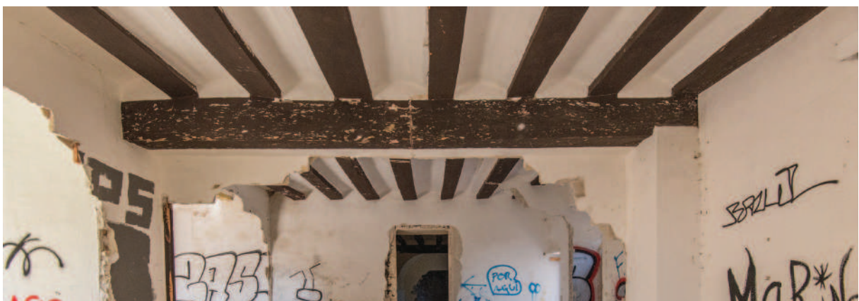
Foto 6.4.8 - Techo de estructura de vigas de madera visto con abovedado cerámico entre vigas
