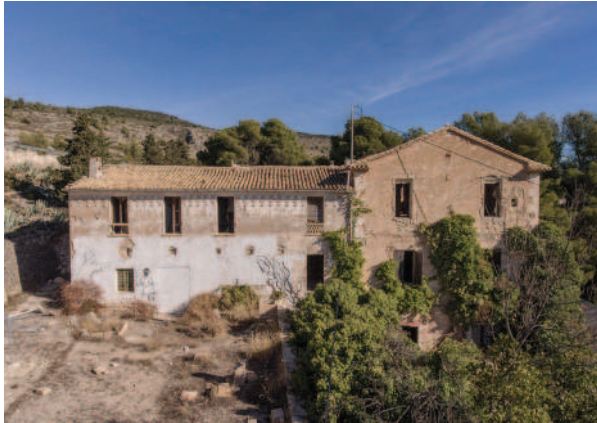
Foto 4.2.5.4 - Alzado oeste visto desde drone
