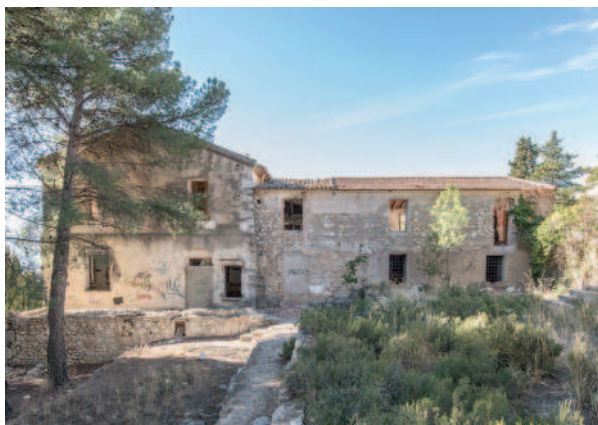
Foto 9.2.1.3 - Zona de acceso en la fachada este
