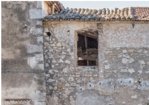
Foto 6.6.6 - Muro de piedra
