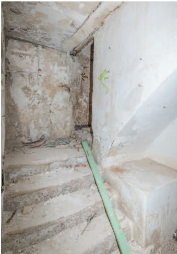
Foto 6.2.7 - Pavimento de piedra de escaleras
