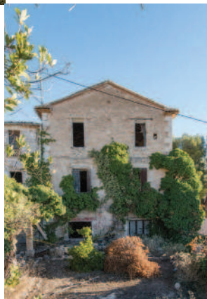
Foto 4.2.5.5 - Alzado oeste nave principal vista persona
