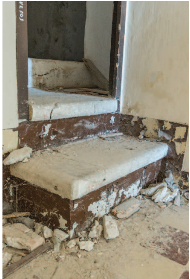
Foto 6.2.6 - Pavimento de piedra de escaleras
