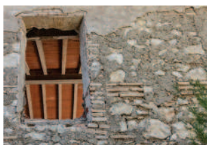
Foto 4.3.1 - Muro de fachada
