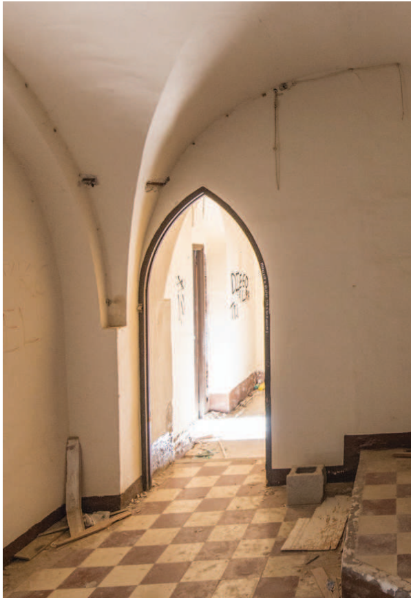
Foto 4.3.1.2 - IO - 02.C) Arco ojival de paso con carpintería
