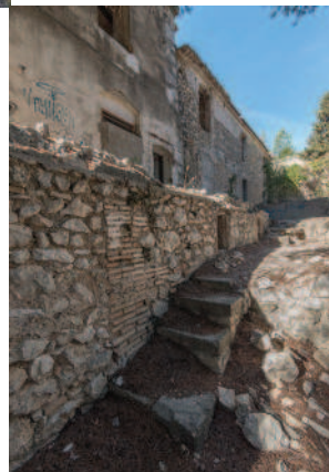
Foto 4.2.5.8 - Conexión de la fachada con las antiguas acequias
