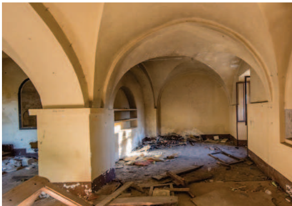
Foto 6.6.1 - Bóveda de arista estructuralmente en buen estado
