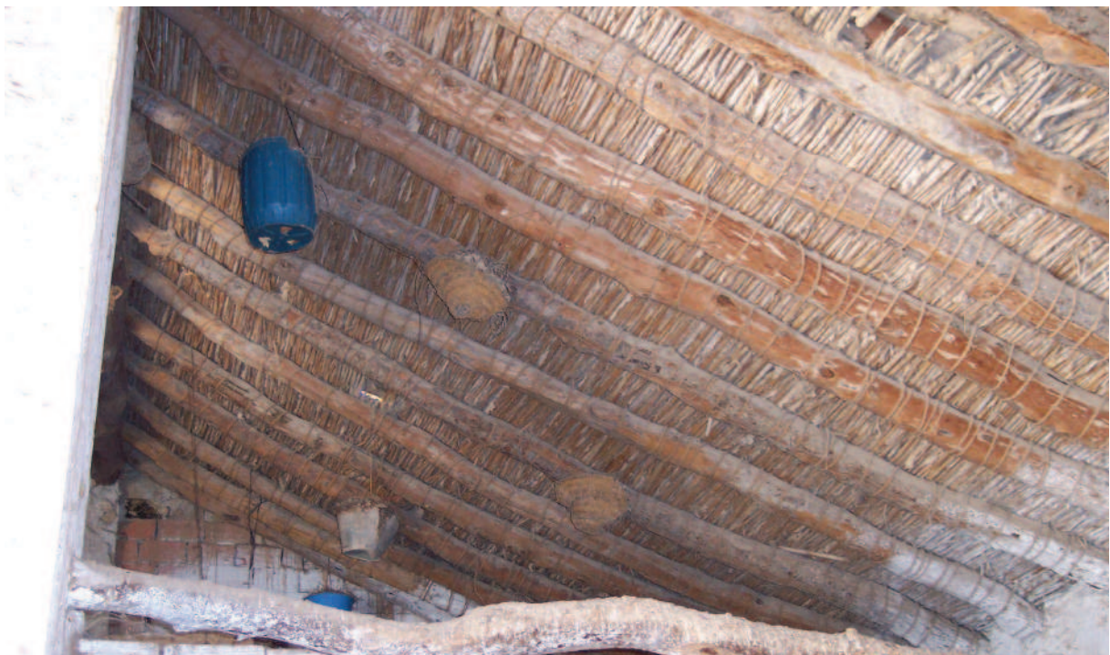
Foto 10.3.3.2 - Techado tradicional de fustes de pino y cañas.
