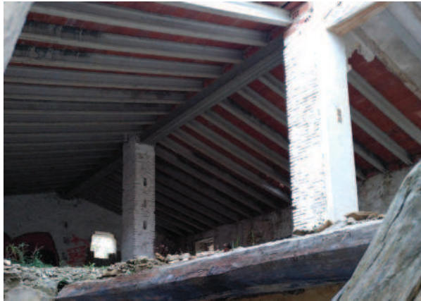
Foto 6.6.8 - Estructura que ha sido reformada
