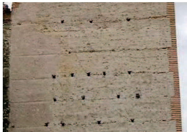
Imagen y Foto 10.3.1.1 - Mechinales que aparecen en edificios históricos y que se han respetado a la hora de restaurarlos
