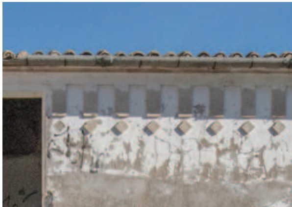
Foto 6.3.6 - Detalle de cornisa
