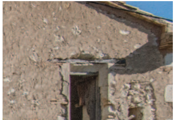
Foto 6.3.7 - Detalle de muro
