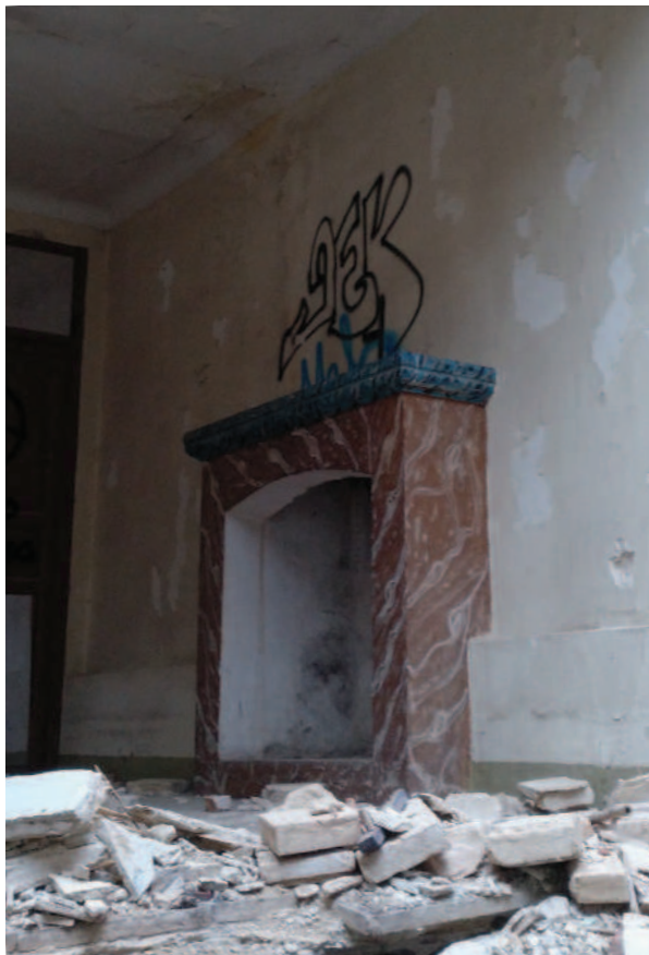
Foto 4.3.3.1 - I2 - 14.B) Chimenea
