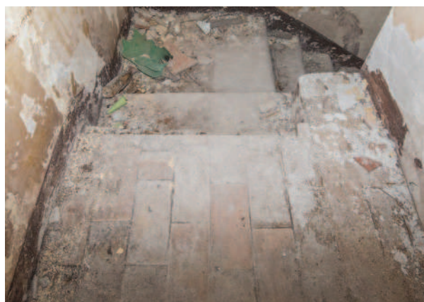
Foto 4.3.2.2 - II -18.B) Pavimento cerámico
