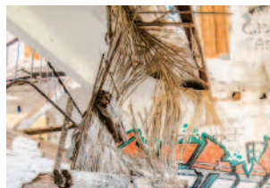
Foto 4.3.6 - Techo de cañizo
