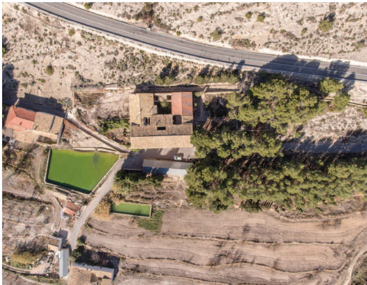
Foto 4.1.2.1 - Foto aérea del recinto
