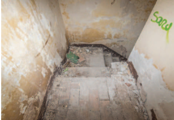
Foto 6.2.4 - Pavimento ladrillo cerámico
