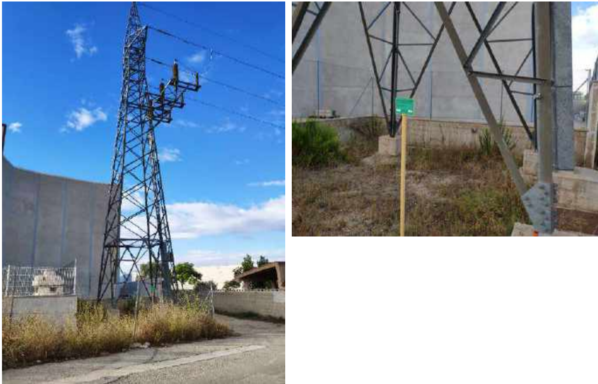
Fotografía 58 [Izquierda] Vista de torre eléctrica en calle Cádiz. [Derecha] Vista las cimentaciones de la torre eléctrica. Fuente: Elaboración propia. Fecha: 08/09/2020
